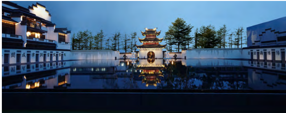
建筑立面与景观照明
